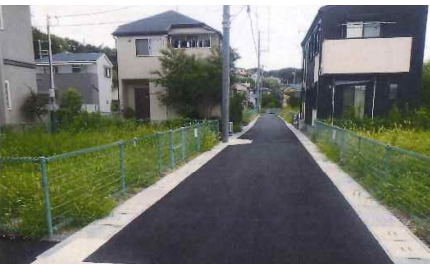
D7/市道81号・829号道路改良工事 【令和3年度完成】
