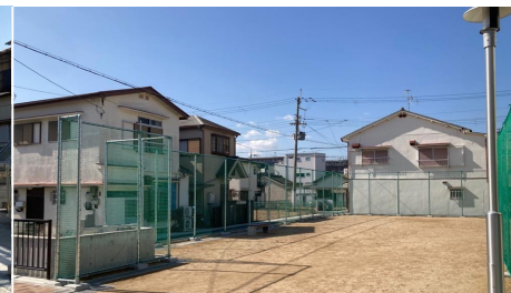
K7/高芝憩い公園整備工事 【令和5年度完成】
