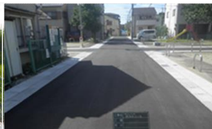
D13/摂代地区側溝新設工事 【令和6年度完成】
