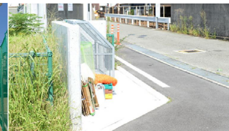
D3/市道22号隅切り工事 【令和2年度完成】
