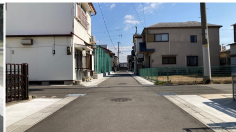
D13/高芝地区側溝新設工事 【令和5年度完成】
