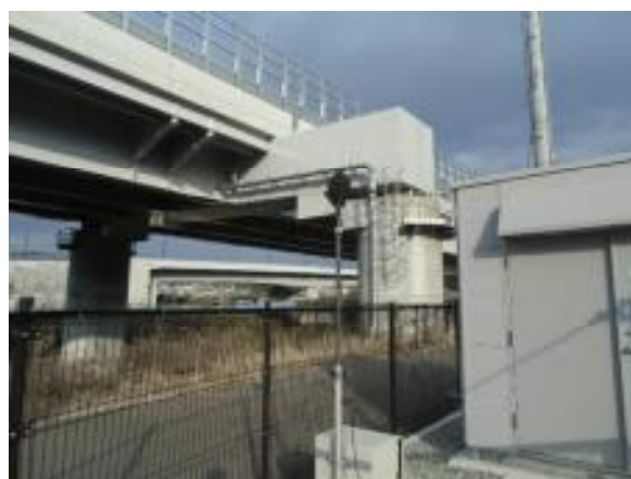
【図 7-3 測定の様子（川西文珠橋局）】
