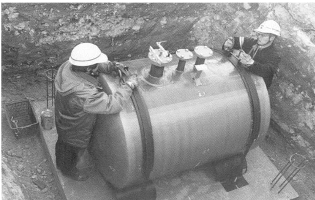
給油取扱所に埋設するタンクの検査
