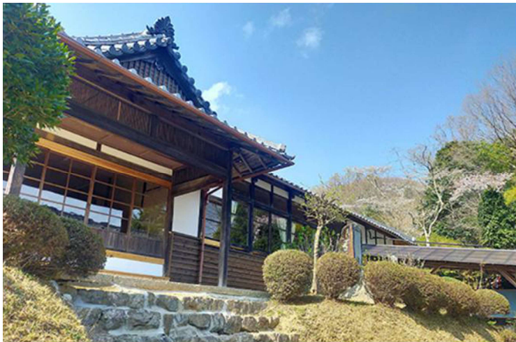
黒川里山センター北棟
